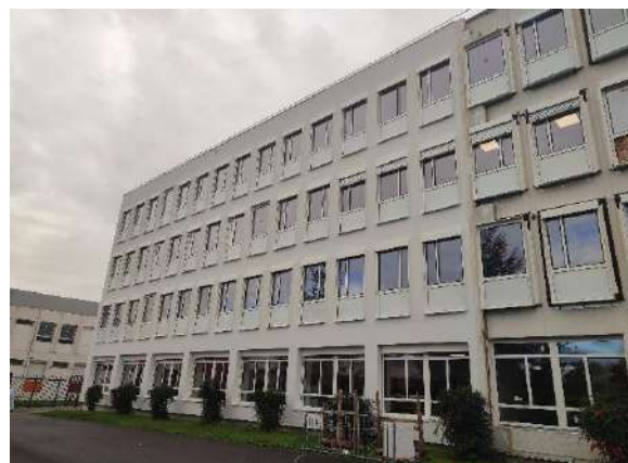
Bâtiment INSPÉ Ranguel, travaux de rénovation énergétique - © G. Girard
