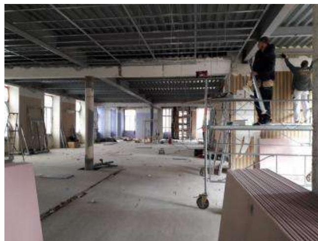
Chantier campus de Foix, novembre 2022 – © ADUA
