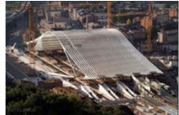
Toiture principale de la gare de Liège
