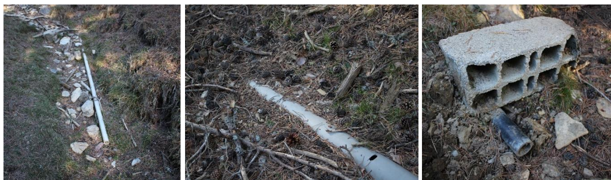
Figure 15 : Anciens tuyaux de canalisation
