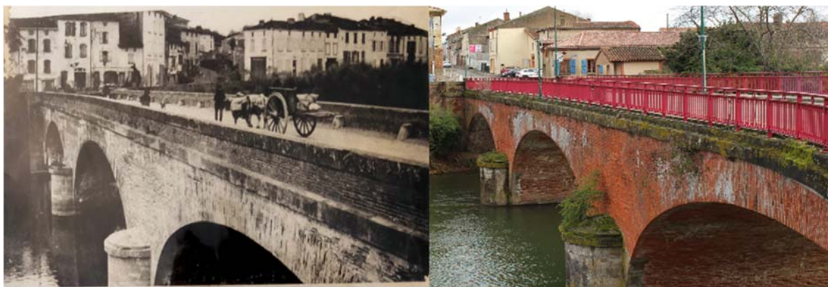
FIGURE 12 - PONT DE SAVERDUN VUE DE LA RIVE GAUCHE VERS 1990 ET EN 2022
