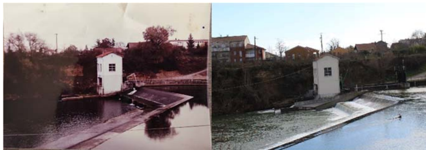
FIGURE 10 - REGIE ELECTRIQUE DE SAVERDUN EN RIVE DROITE VERS 1900 ET EN 2022
