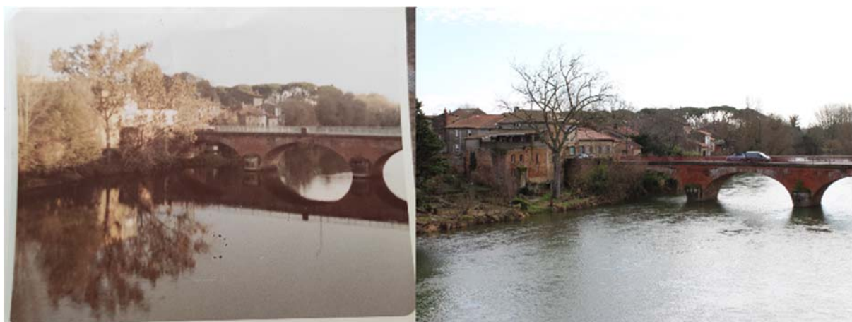
FIGURE 11 - PONT DE SAVERDUN DANS LES ANNEES 1990 ET EN 2022
