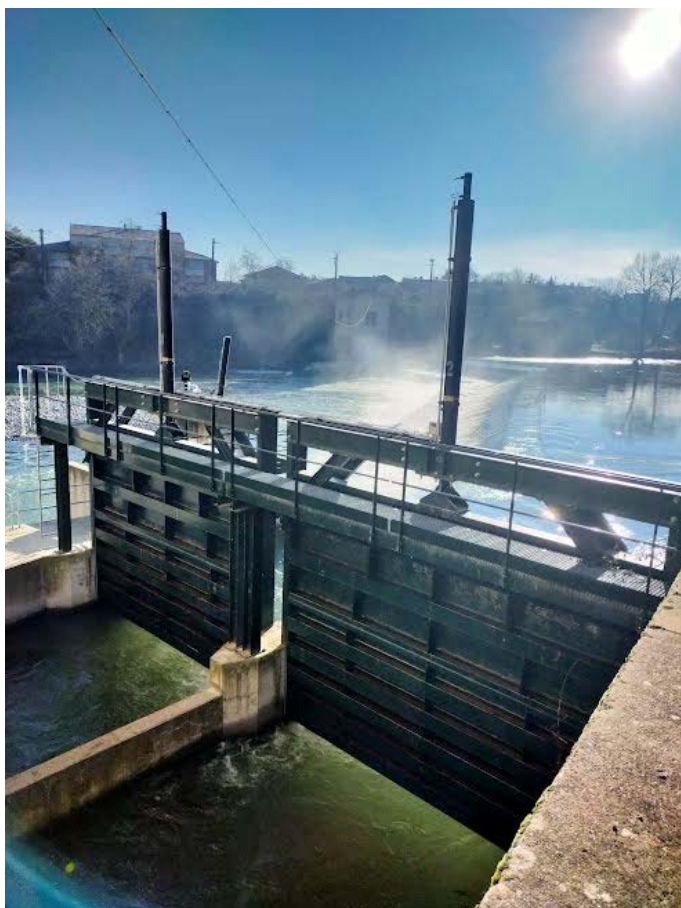
FIGURE 18 - CENTRALE HYDROELECTRIQUE DE SAVERDUN, PRISE DEPUIS LE PARKING DE LA CAVALERIE
