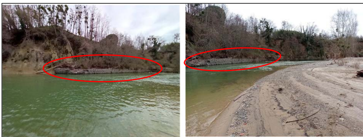
FIGURE 44 - PHOTOGRAPHIES DE L'OUVRAGE DE PROTECTION SITUE A BONNAC
