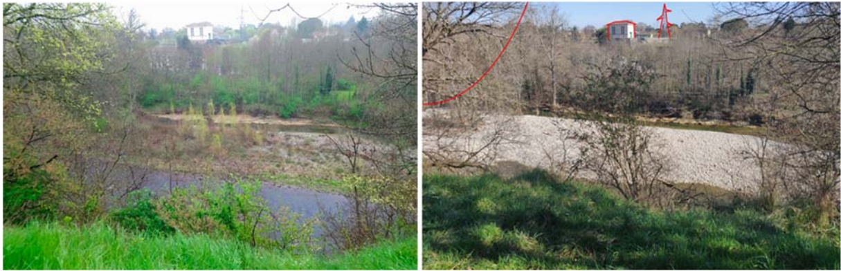
FIGURE 69 - PHOTOGRAPHIES DU POINT "BONNAC POINT HAUT" VUE DU CASTELA EN AVRIL 2019 (A GAUCHE) ET EN FEVRIER 2022 (A DROITE). SOURCE : SYMAR VAL D'ARIEGE, MASTER 2 GEMO
