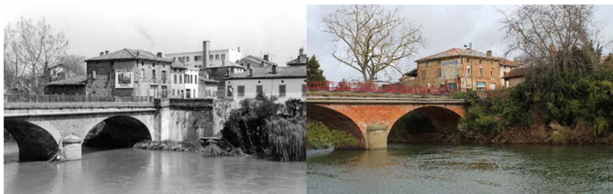
FIGURE 14 - PONT DE SAVERDUN EN 1978 ET 2022
