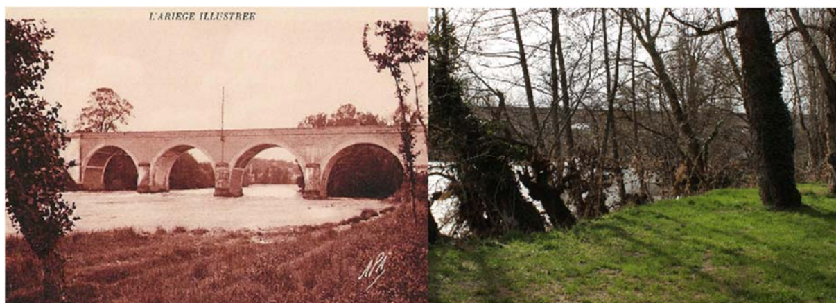
FIGURE 17 - L'ARIEGE VUE DU PONT DE LA VOIE FERREE DEPUIS LA RIVE GAUCHE EN 1940 ET EN 2022
